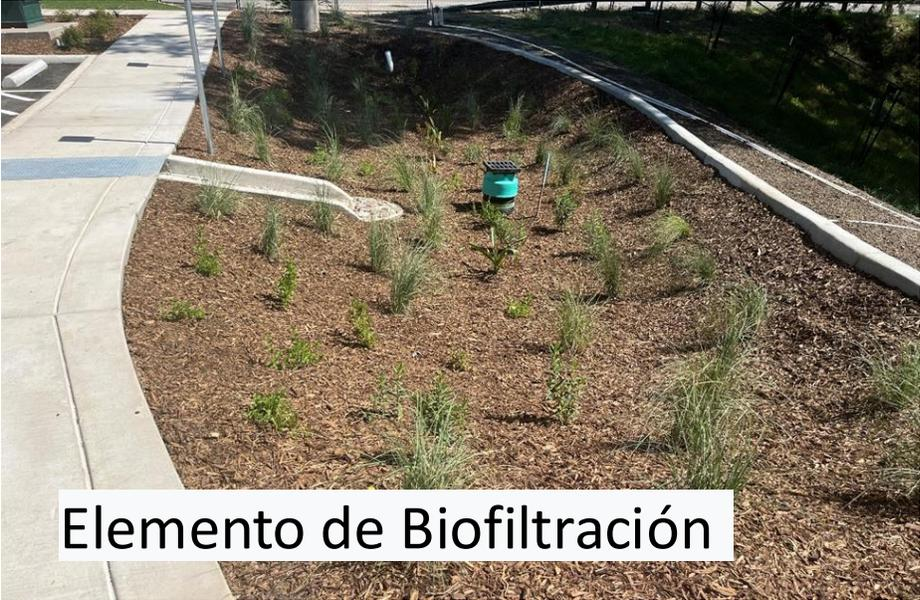
Elemento de Biofiltración
