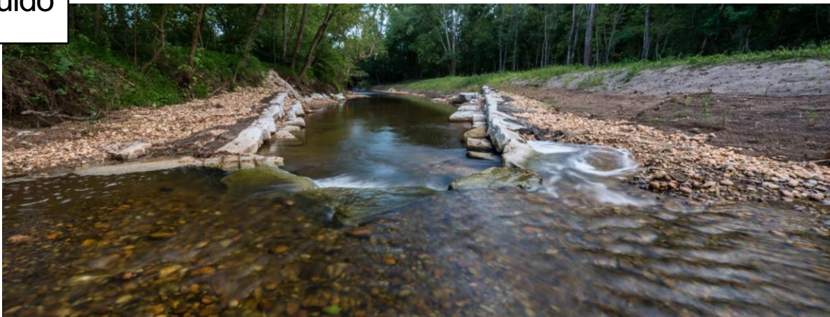
Construcción en Forma de Cruz
